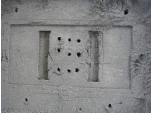
Fig. 14. Penetrometer test points
